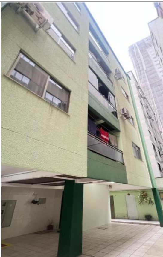
Foto 6 – Foto lateral do imóvel avaliando
