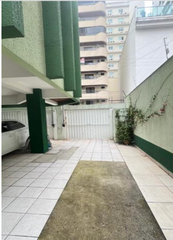
Foto 3 – Acesso a vaga e circulação
