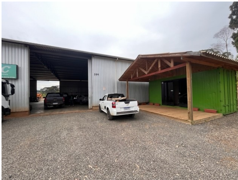
Foto 2: imagem do escritório estrutura de container.
