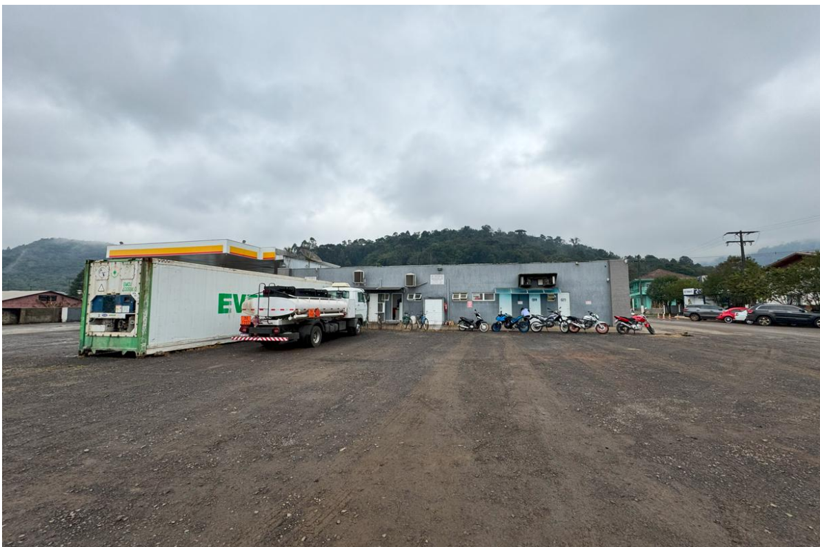
Vista dos fundos 02
