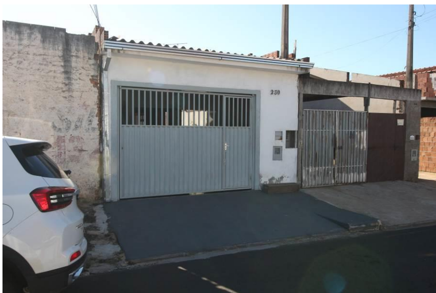
Foto 01: Fachada do imóvel nº 230A.
