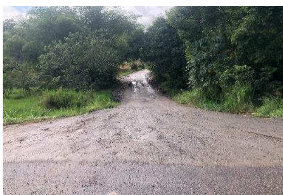
VIA DE ACESSO AO TERRENO
