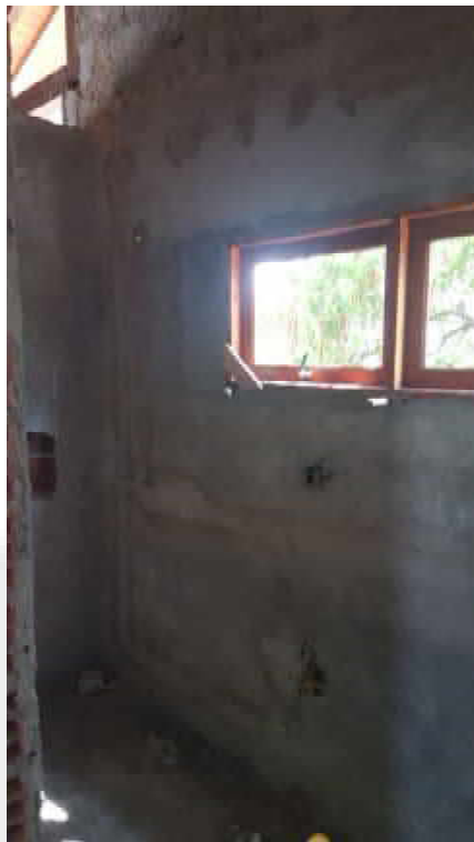
Figura 18 - Banheiro 03 - Fonte: Própria (17.09.2020)
