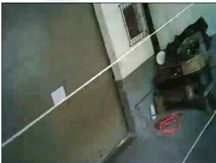
Figura 28 - Recuo frontal do galpão - Fonte: Própria (17.09.2020)
