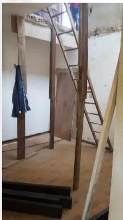
Figura 12 - Sala - Fonte: Própria (17.09.2020)
