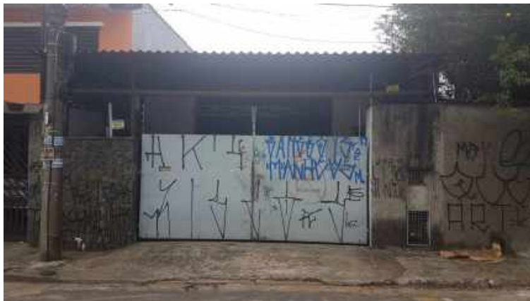
Figura 27 - Fachada do galpão - Fonte: Própria (17.09.2020)
