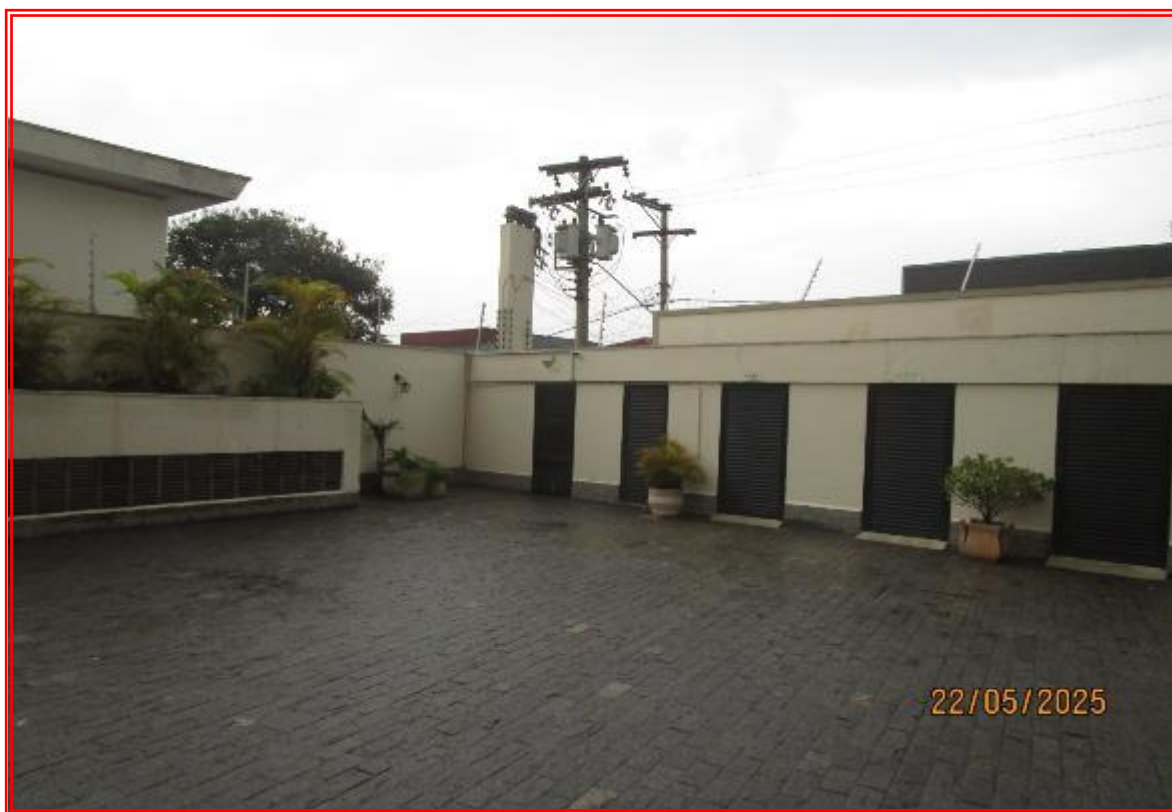
Foto n° 16: Vista parcial da área de uso comum dos fundos, onde se localiza o portão (fechado) voltado para a Rua Dr. Aires Martins Torres.
