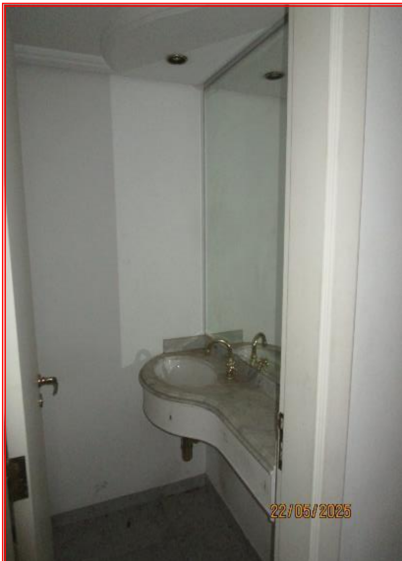
Foto nº 30: Vista parcial do lavabo.
