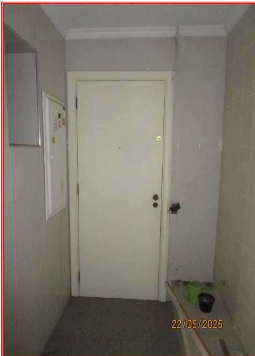
Foto nº 48: Vista geral do hall de entrada da área de serviço.
