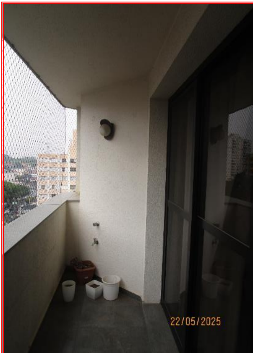
Foto nº 26: Vista geral da sacada.
