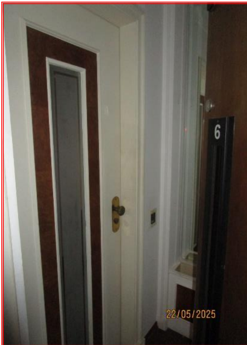
Foto nº 24: Vista parcial do hall de elevador e de entrada social do apartamento nº 62.
