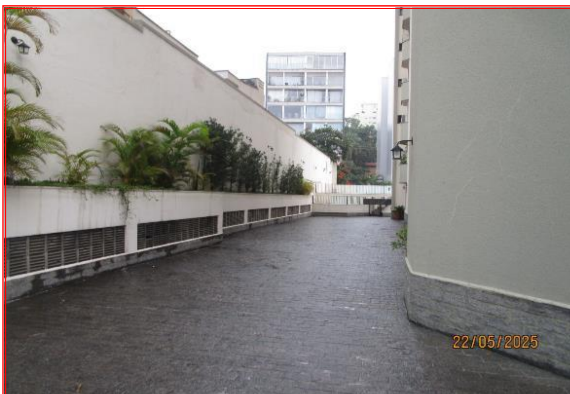
Foto n o 12: Vista da área de uso comum lateral.
