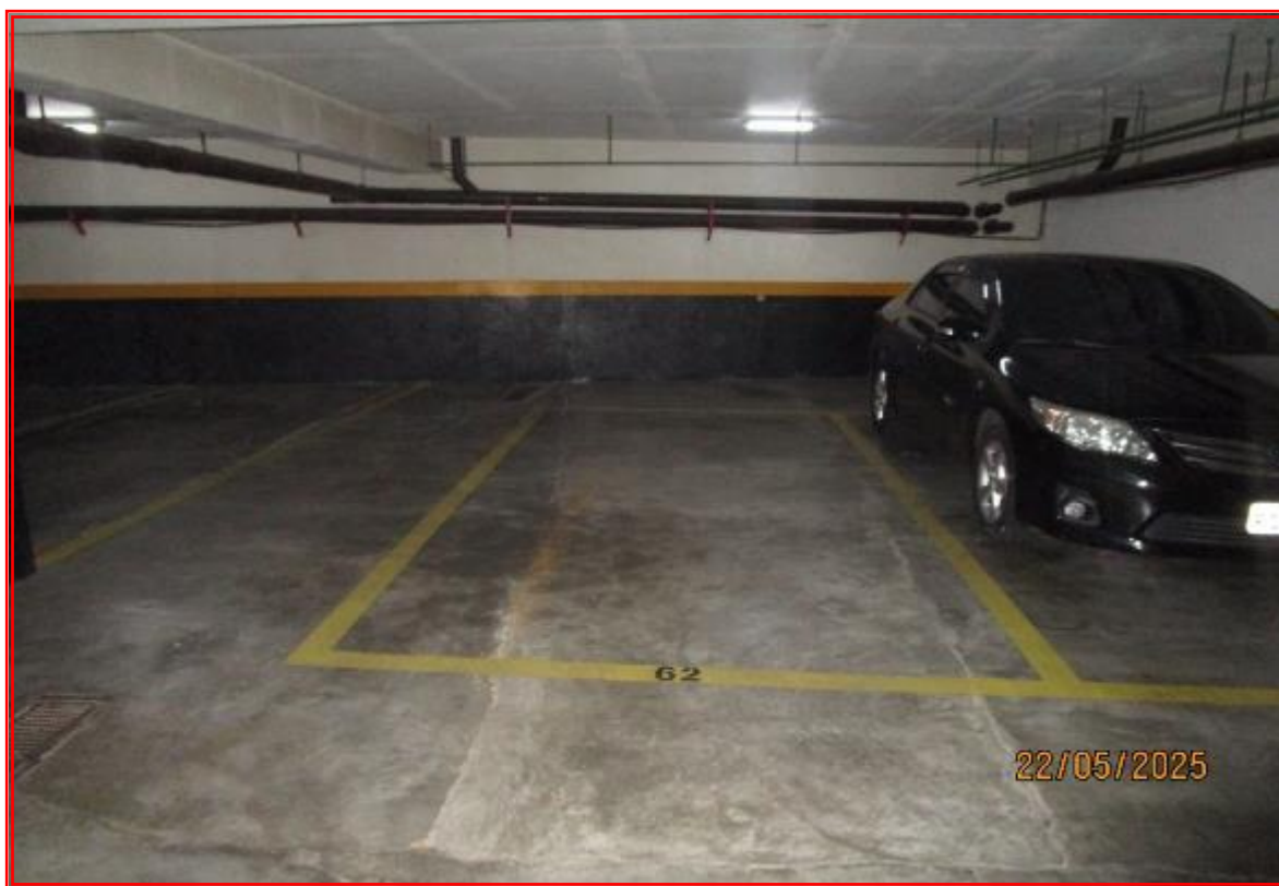
Foto n° 22: Vista geral da vaga n° 62 de uso da unidade avalianda.
