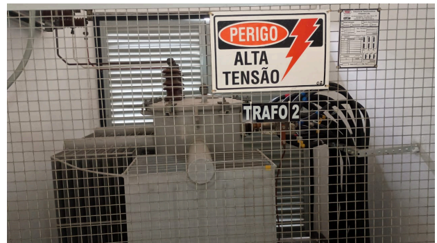
Figura 1 - Transformadores 1000kVA ITAM, ano 2005
