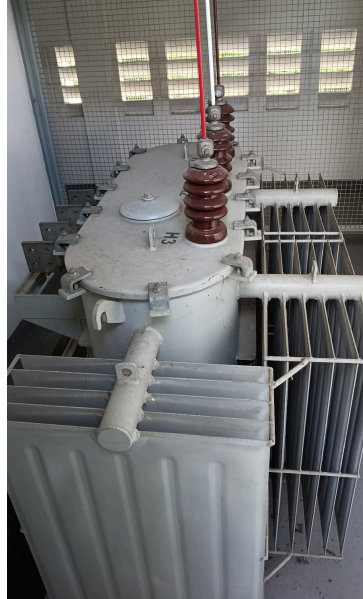
Figura 3 - Transformador 300kVA
