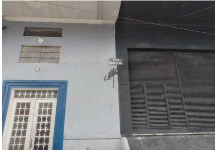
Representação Fachada Principal Descrição Data Foto 15/05/2023
