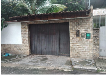
Representação Fachada Principal Descrição Data Foto 15/05/2023
