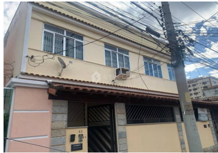
Representação Fachada Principal Descrição Data Foto 15/05/2023
