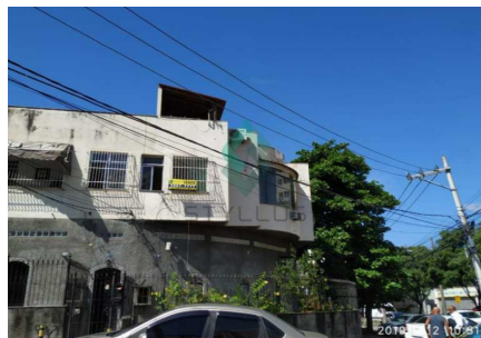
Representação Fachada Principal Descrição Data Foto 15/05/2023
