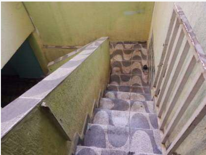
Escada - acesso a casa subsolo
