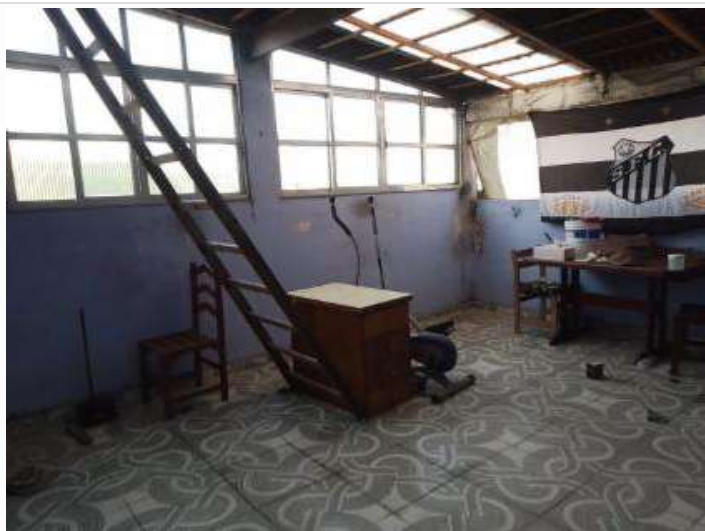
Casa 2 - Área de serviço - vista 2
