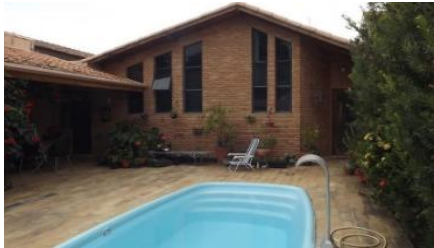
Representação Fachada Principal Descrição Data Foto 17/05/2024
