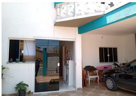
Representação Fachada Principal Descrição Data Foto 27/10/2022
