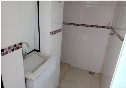
Representação Banheiro social Descrição Data Foto 27/10/2022
