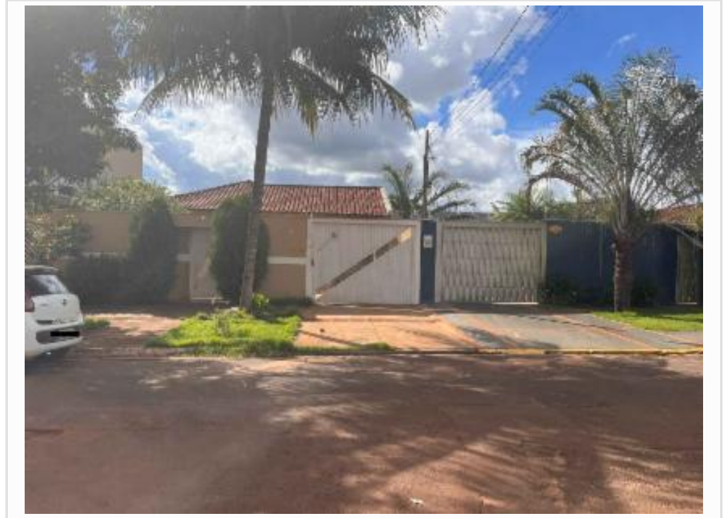
vista parcial da fachada
