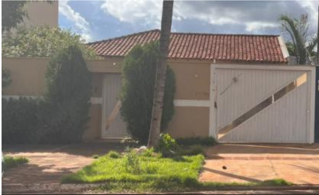
vista parcial da fachada
