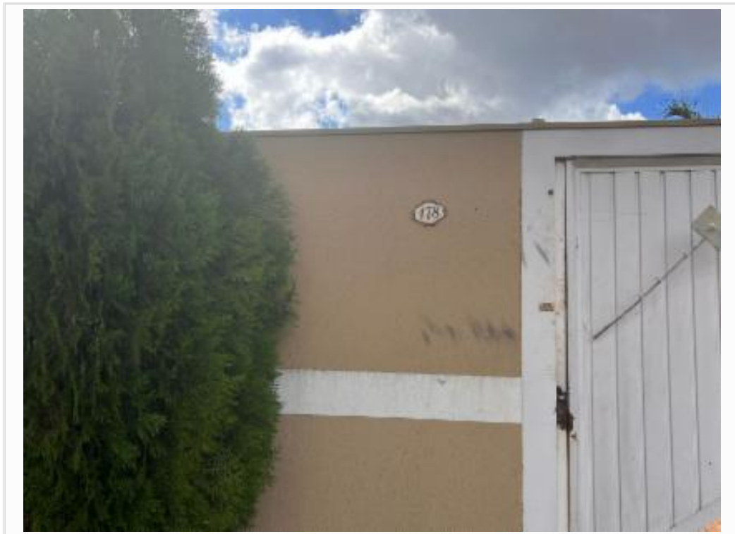
vista parcial da fachada
