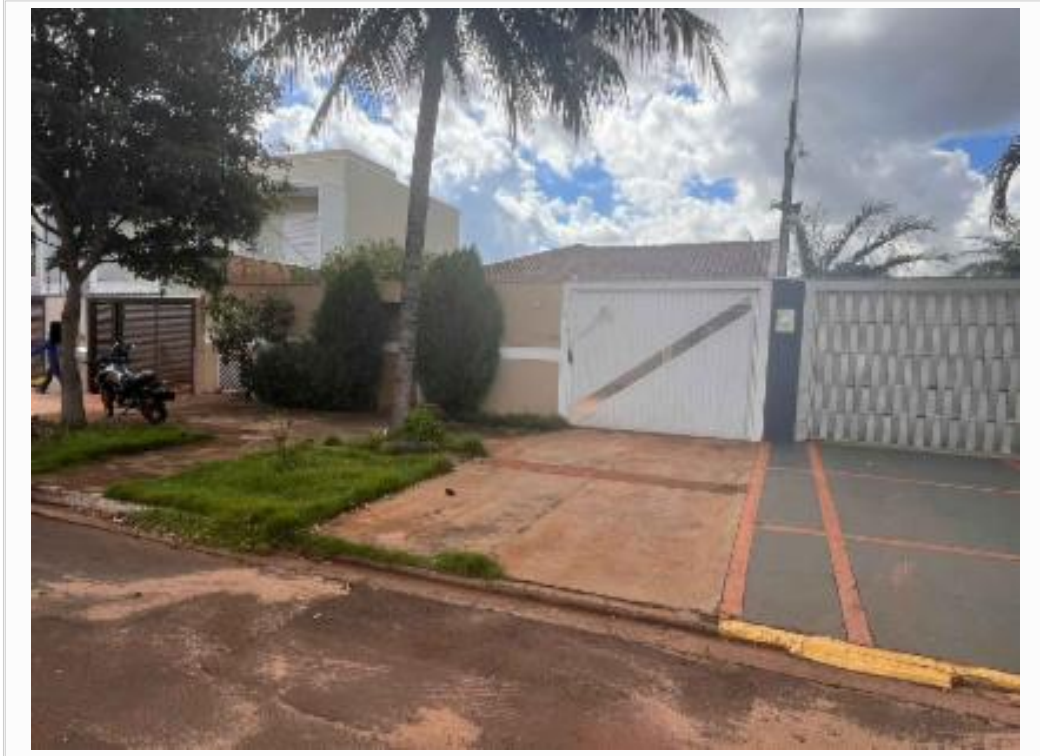
vista parcial da fachada
