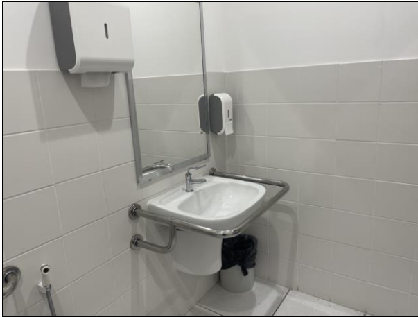
Superior - Banheiro PNE
