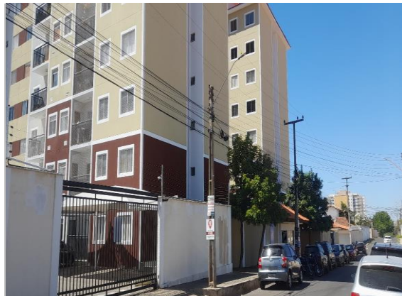
Fachada do avaliando
