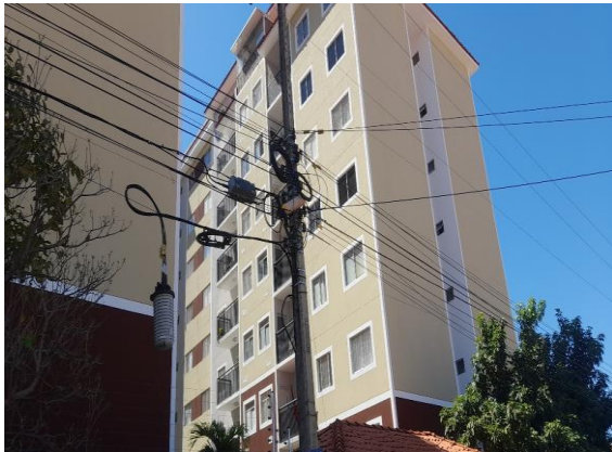
Fachada do avaliando
