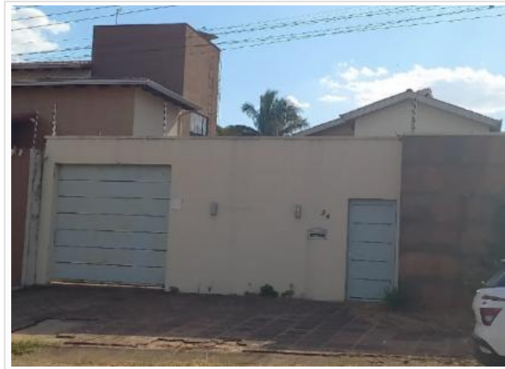
vista parcial da fachada
