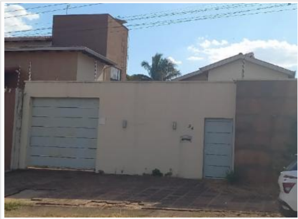
vista parcial da fachada
