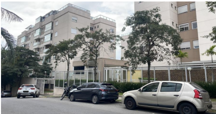
Representação Fachada Principal Descrição Data Foto 02/05/2025
