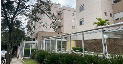
Representação Fachada Principal Descrição Data Foto 02/05/2025
