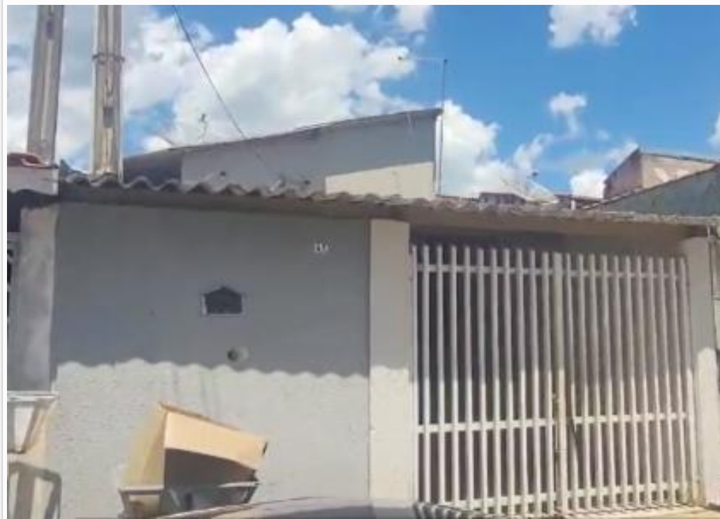
vista parcial da fachada
