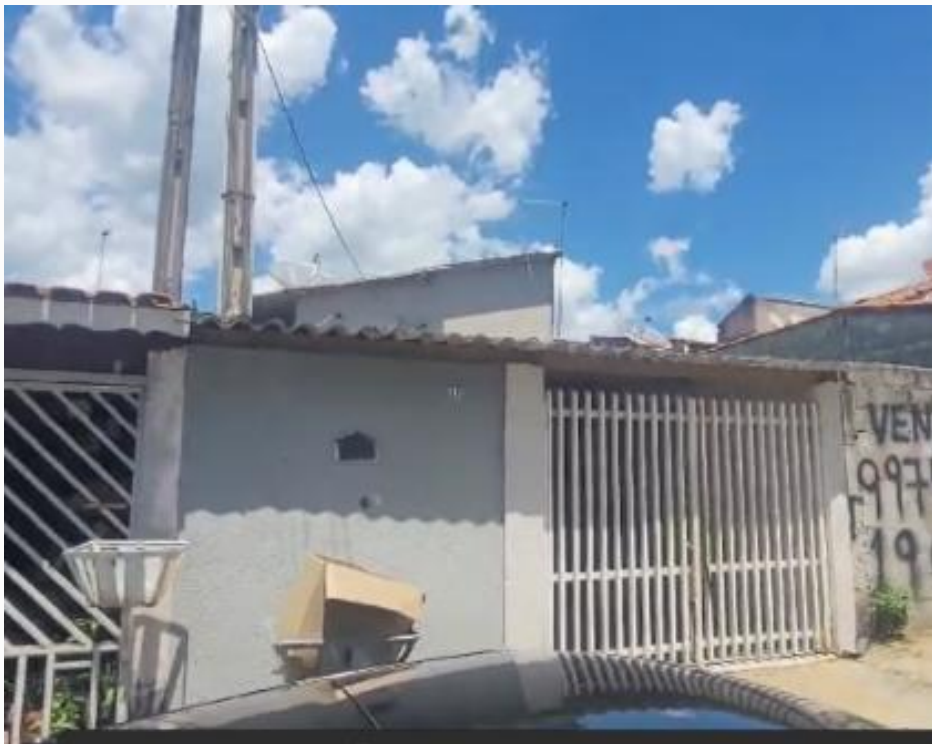
vista parcial da fachada
