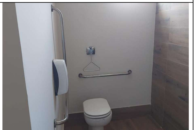
Vista interna do imóvel em estudo, banheiro PNE.
