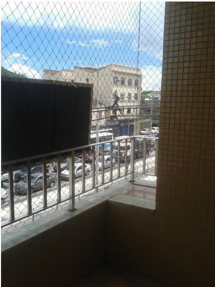
Representação Varanda / Sacada Descrição Data Foto 07/02/2018
