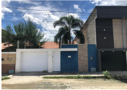
Representação Vista da Rua Descrição Vizinho Esquerdo Data Foto 16/05/2024
