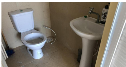
Representação Banheiro Descrição Banheiro 03 Data Foto 04/06/2024
