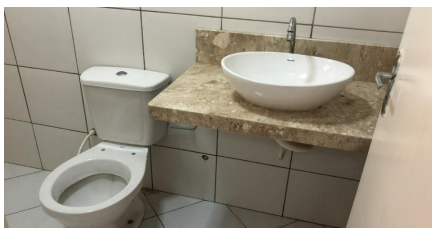
Representação Banheiro Descrição Banheiro 02 Data Foto 04/06/2024
