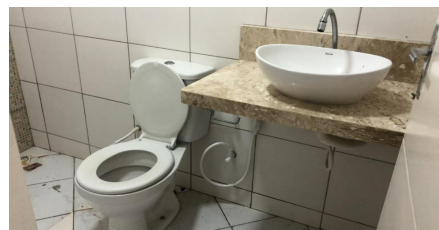
Representação Banheiro Descrição Banheiro 01 Data Foto 04/06/2024
