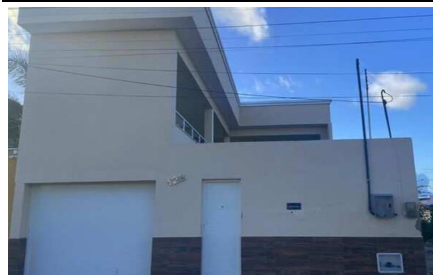
Representação Fachada Principal Descrição Data Foto 21/05/2024
