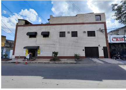
Representação Fachada Principal Descrição Data Foto 11/01/2024
