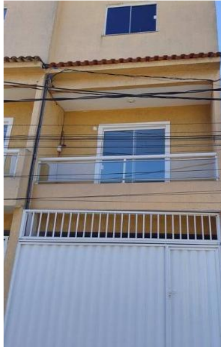
Representação Fachada Principal Descrição Data Foto 12/01/2024
