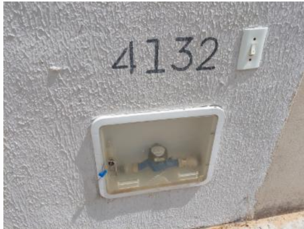
Identificação numérica/medidor de água
