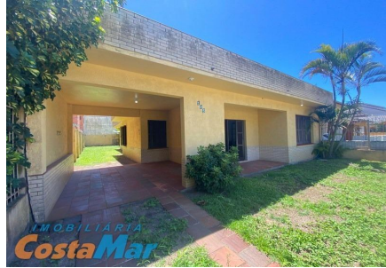
Representação Fachada Principal Descrição Data Foto 09/12/2022
