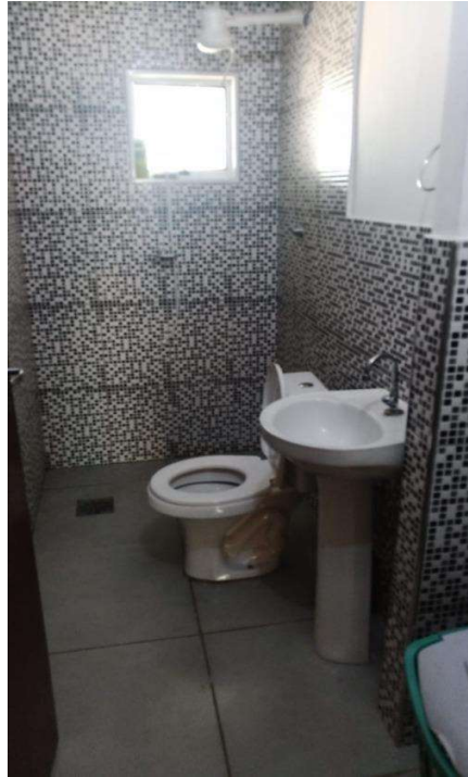
Representação Banheiro social Descrição Data Foto 18/11/2022
