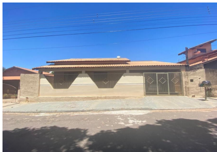
Representação Fachada Principal Descrição Data Foto 26/10/2022
