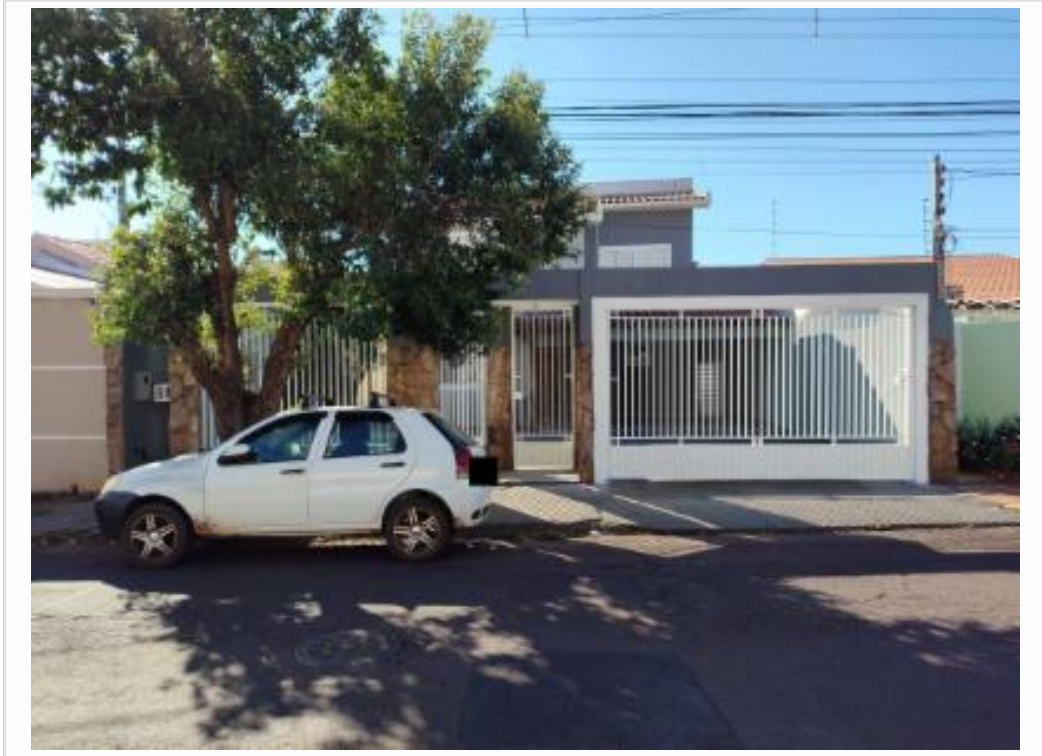
Fachada do avaliando
