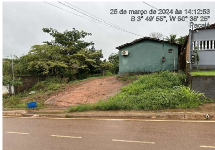
25 de março de 2024 às 14:12:53 S 3° 49' 55", W 50° 38' 25" Pacajá Representação Fachada Principal Descrição Vizinho frontal Data Foto 05/04/2024
