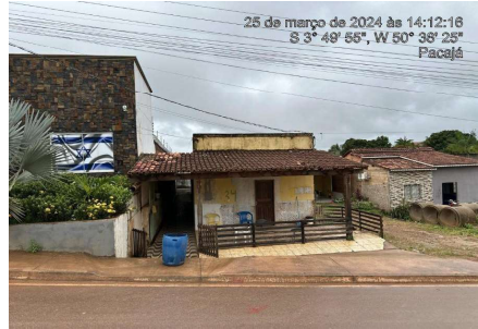
25 de março de 2024 às 14:12:16 S 3° 49' 55", W 50° 38' 25" Pacajá Representação Fachada Principal Descrição Vizinho direito Data Foto 05/04/2024
