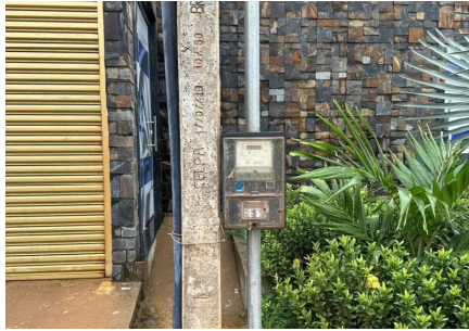
Representação Fachada Principal Descrição Medidor Data Foto 05/04/2024
