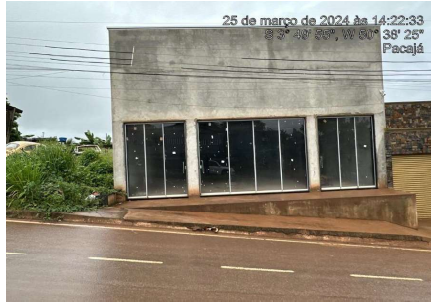
25 de março de 2024 às 14:22:33 S 3° 49' 55", W 50° 38' 25" Pacajá Representação Fachada Principal Descrição Vizinho esquerdo Data Foto 05/04/2024
