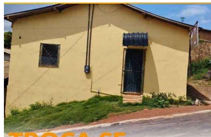
Representação Fachada Principal Descrição Data Foto 05/04/2024
