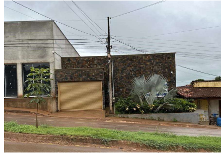
Representação Fachada Principal Descrição Fachada do avaliando - Vista 02 Data Foto 05/04/2024
