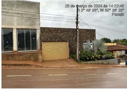
25 de março de 2024 às 14:22:45 S 3° 49' 55", W 50° 38' 25" Pacajá Representação Fachada Principal Descrição Fachada do avaliando - Vista 01 Data Foto 05/04/2024
