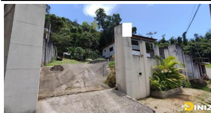
Representação Fachada Principal Descrição Data Foto 04/07/2024
