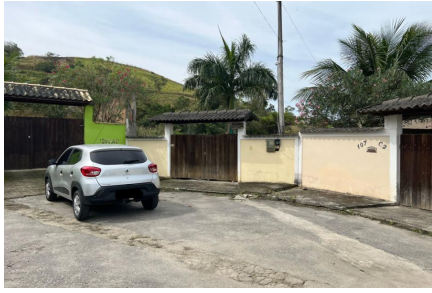
Representação Fachada Principal Descrição Data Foto 21/08/2023
