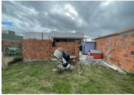
Representação Fachada Principal Descrição Data Foto 17/01/2023
