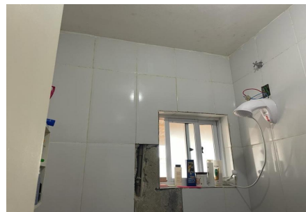
Representação Banheiro social Descrição Data Foto 17/01/2023
