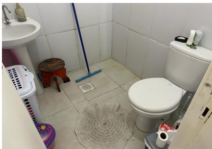
Representação Banheiro social Descrição Data Foto 17/01/2023
