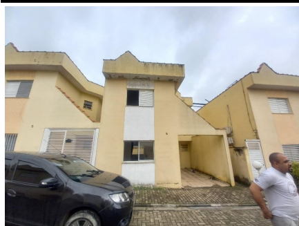
Representação Fachada Principal Descrição
