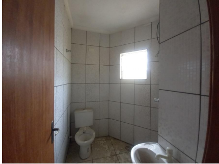
Representação Banheiro social Descrição Data Foto 10/06/2022
