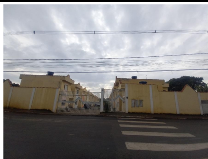
Representação Fachada Principal Descrição
