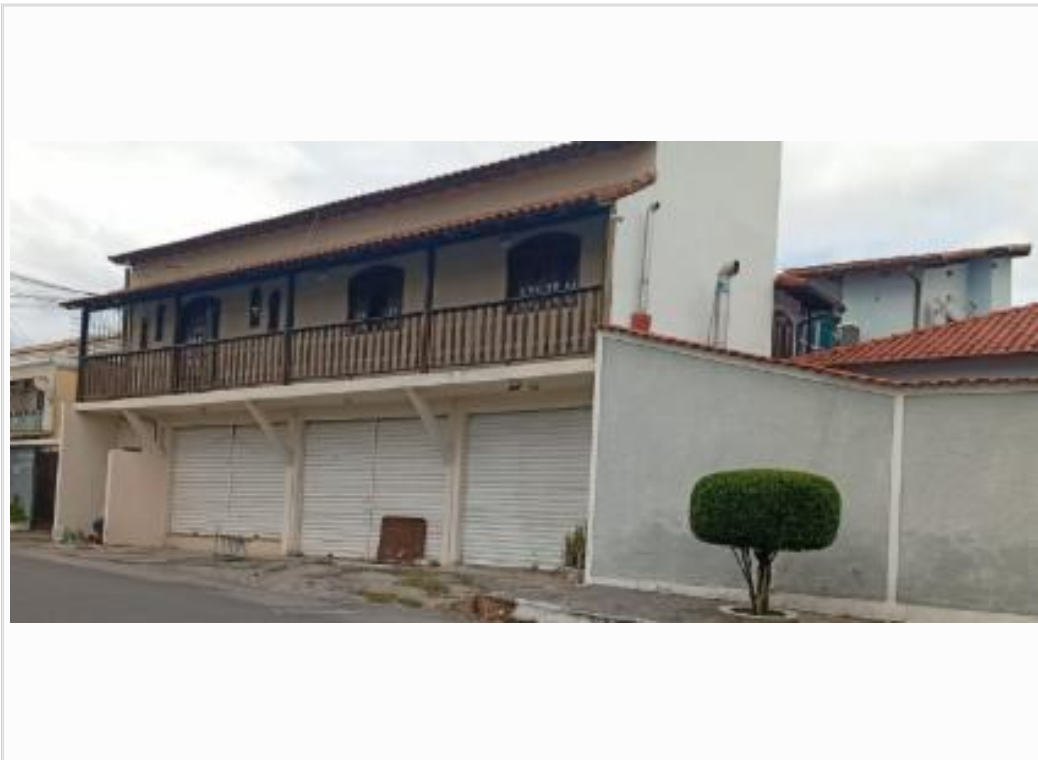
vista parcial da fachada
