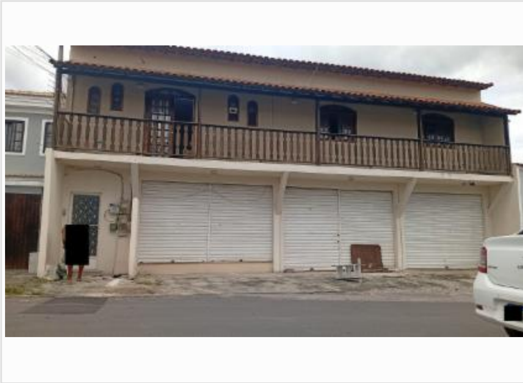
vista parcial da fachada
