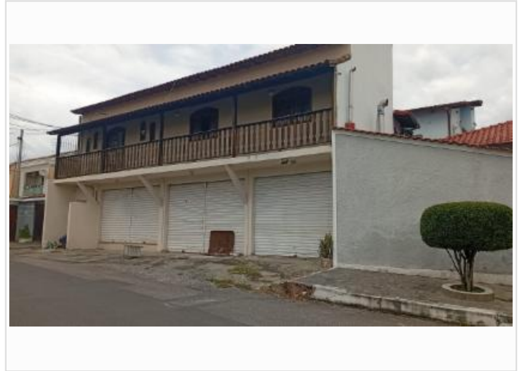
vista parcial da fachada
