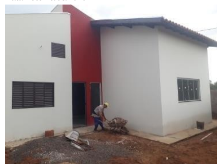
Representação Fachada Descrição frente Data Foto 19/08/2020
