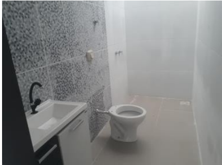
Representação Banheiro Social Descrição Data Foto 19/08/2020
