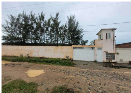
Representação Fachada Principal Descrição Fachada do condomínio 01 Data Foto 10/04/2024
