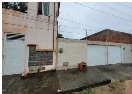
Representação Fachada Principal Descrição Vizinho direito Data Foto 10/04/2024
