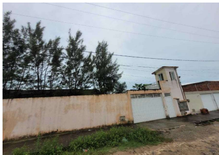
Representação Fachada Principal Descrição Fachada do condomínio 02 Data Foto 10/04/2024
