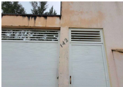
Representação Identificação Numérica Descrição Identificação do condomínio Data Foto 10/04/2024
