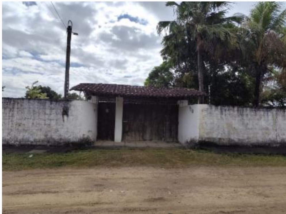
Fachada do avaliando
