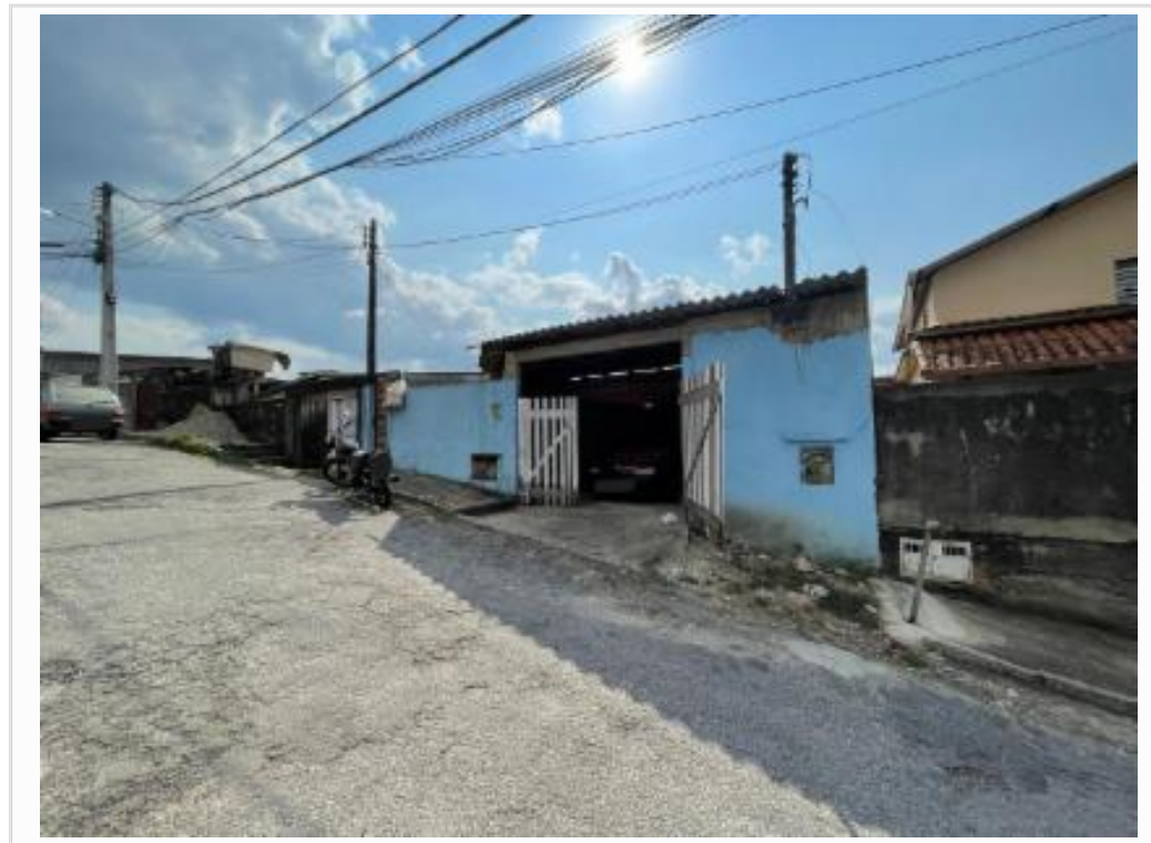
Fachada do avaliando, vista 02
