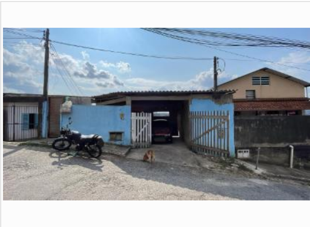
Fachada do avaliando, vista 01
