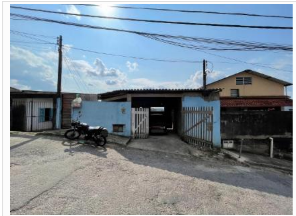
Fachada do avaliando, vista 04
