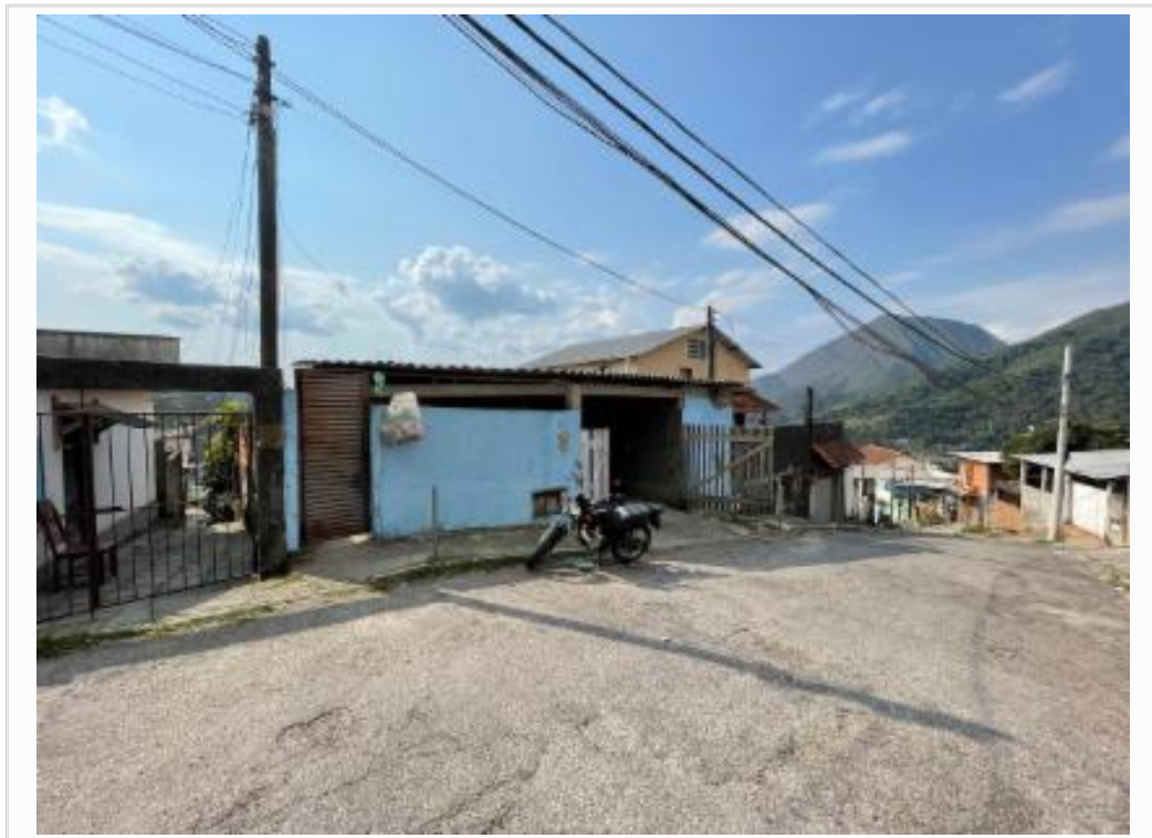
Fachada do avaliando, vista 03
