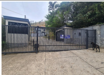
Representação Fachada Principal Descrição . Data Foto 08/10/2025
