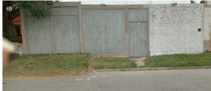
Representação Fachada Principal Descrição Data Foto 08/01/2024
