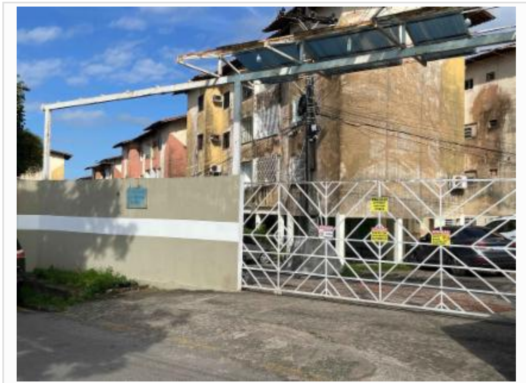
ENTRADA DO CONDOMINIO
