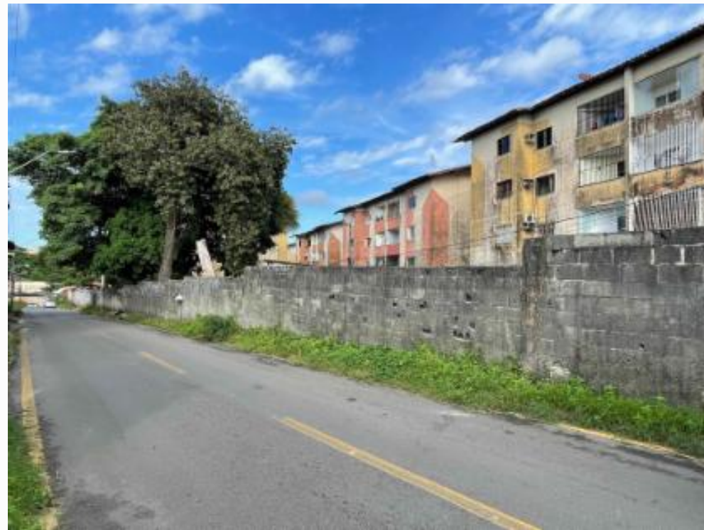
CONTORNO DO PRÉDIO
