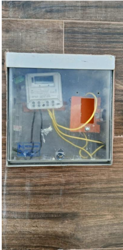
Representação Fachada Principal Descrição Medidor de luz Data Foto 23/11/2023
