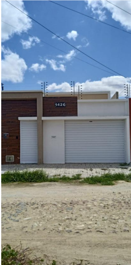
Representação Fachada Principal Descrição Frente do imóvel Data Foto 23/11/2023
