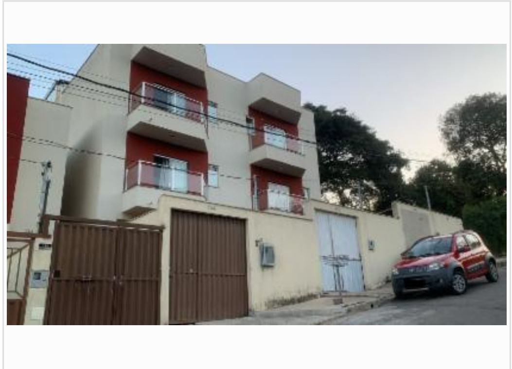
vista da fachada
