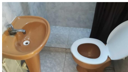
Representação Banheiro Suíte Descrição 2 Data Foto 10/02/2021
