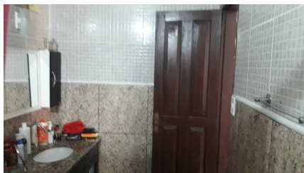
Representação Banheiro Suíte Descrição 1 Data Foto 10/02/2021
