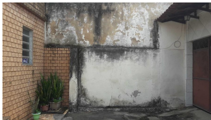
Representação Vista da Rua Descrição VIZINHO DIREITO Data Foto 10/02/2021
