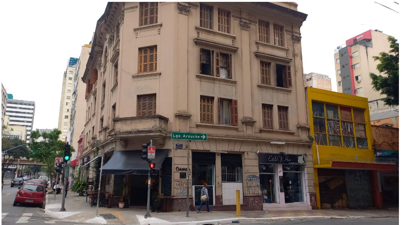
Foto 4 – Vista da Rua
