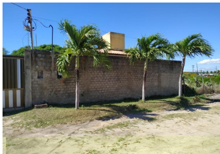
Representação Fachada Principal Descrição Data Foto 25/01/2023
