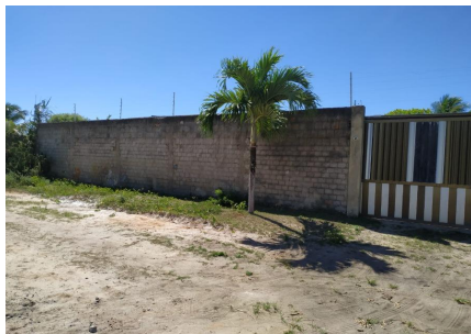
Representação Fachada Principal Descrição Data Foto 25/01/2023
