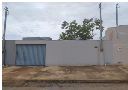
Representação Fachada Principal Descrição Data Foto 31/10/2023
