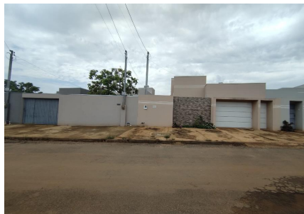
Representação Vista da Rua Descrição Vizinho Direito Data Foto 31/10/2023
