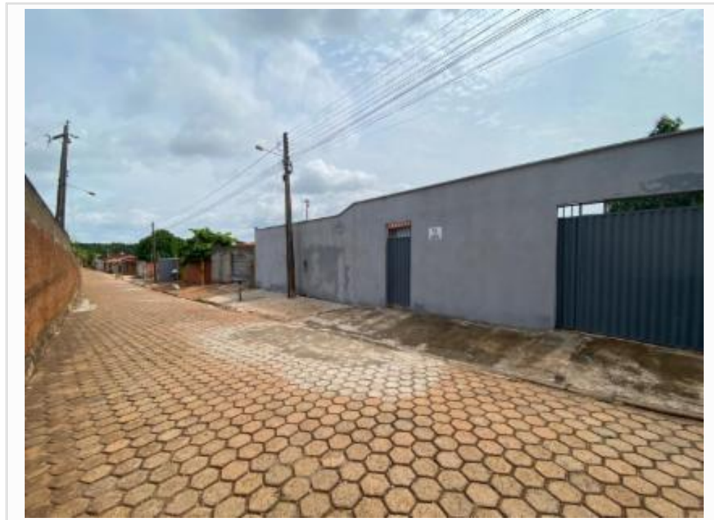
vista parcial da fachada - rua
