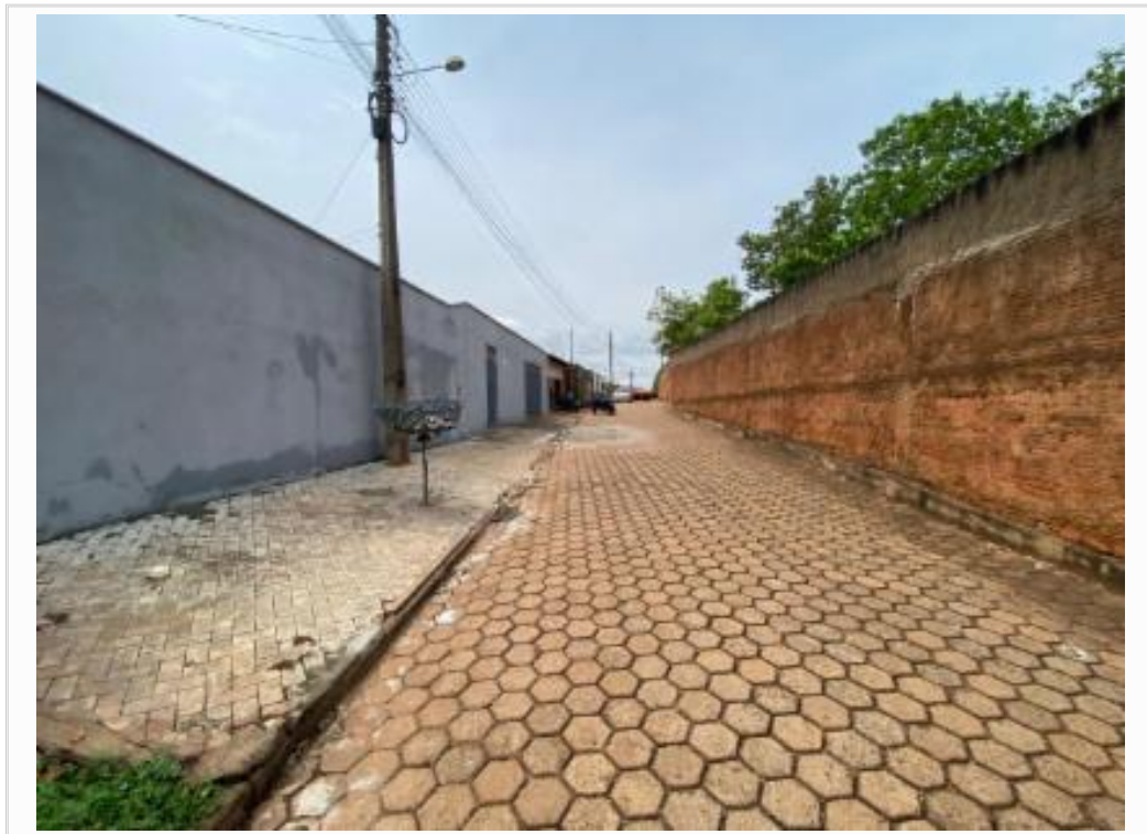
vista parcial da fachada - rua
