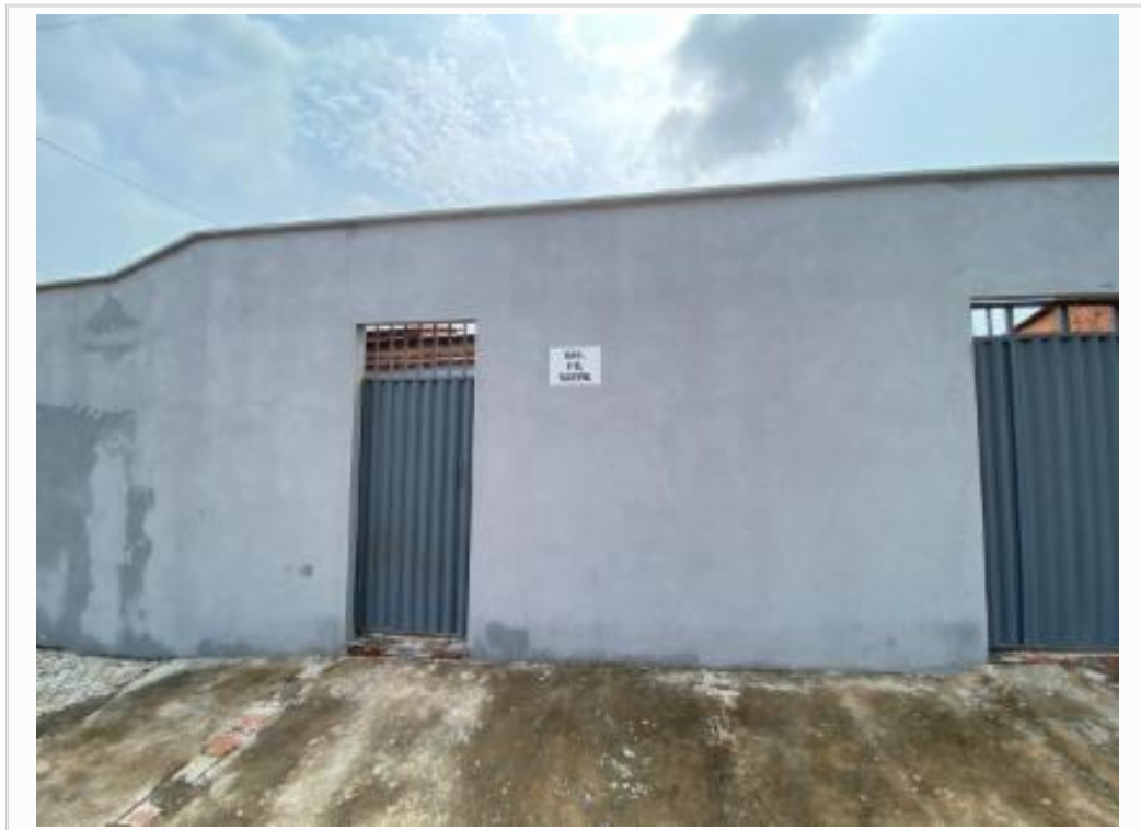
vista parcial da fachada
