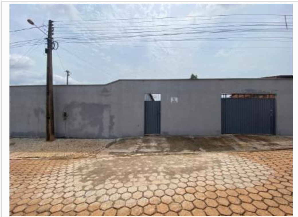
vista parcial da fachada
