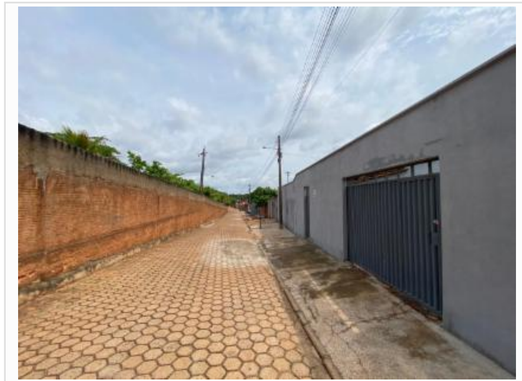
vista parcial da fachada - rua
