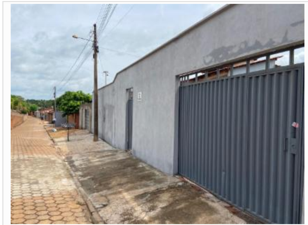
vista parcial da fachada
