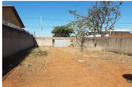
Representação Fachada Principal Descrição Data Foto 27/03/2024
