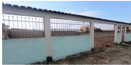
Representação Fachada Principal Descrição Data Foto 27/03/2024
