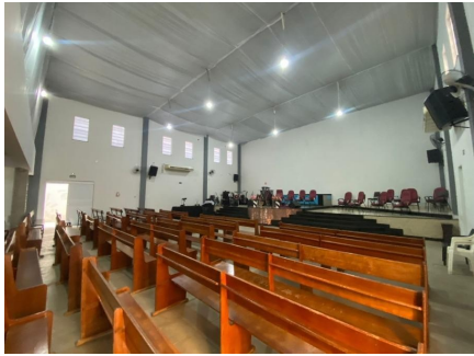
Representação Galpão Descrição TEMPLO Data Foto 12/09/2022
