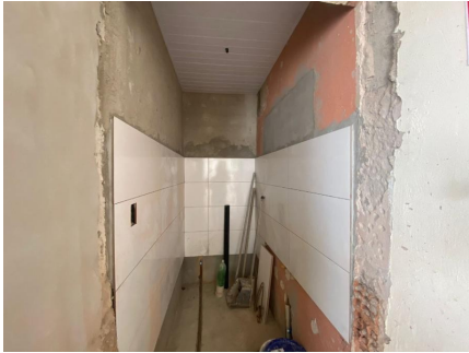
Representação Banheiro social Descrição 02 Data Foto 12/09/2022
