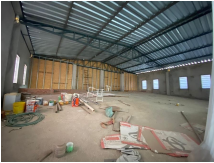
Representação Galpão Descrição MEZANINO Data Foto 12/09/2022
