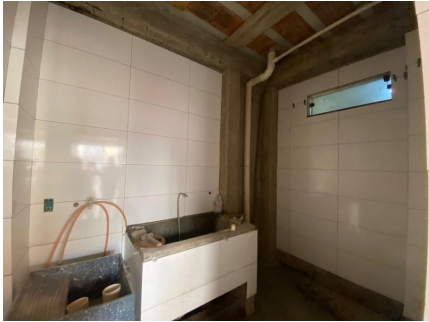
Representação Banheiro Descrição Data Foto 12/09/2022
