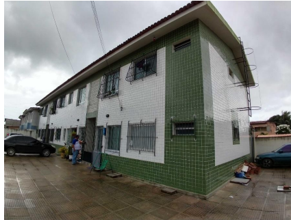
Representação Fachada Principal Descrição Data Foto 30/04/2021
