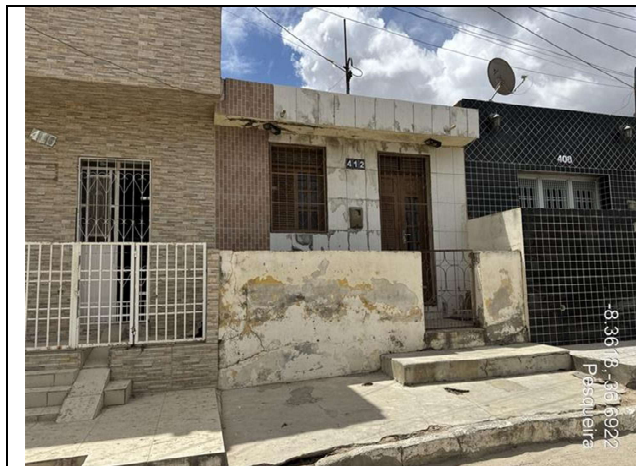
Vista parcial do imóvel em estudo.
